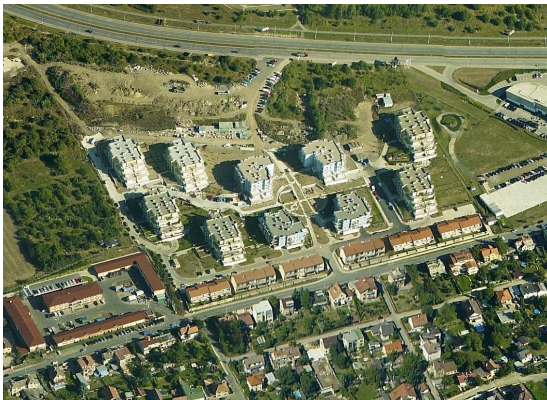
Bytový komplex Řeporyje (© 2012 Google)
