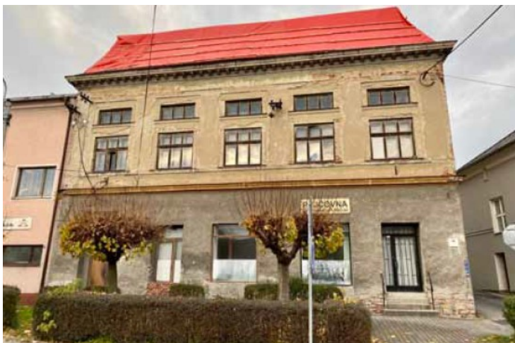
Obrázek 1 Současný stav budovy
