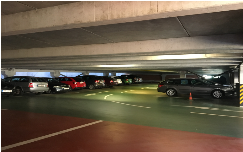
Opava / parkování na průběžné rampě bez sloupů mezi parkovacími místy / zdroj vlastní foto
