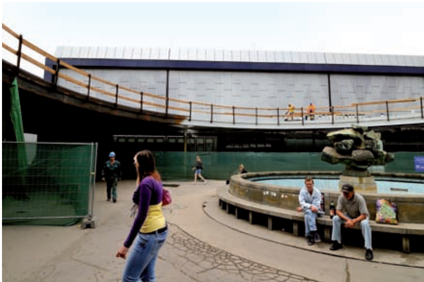
Úprava přednádražích prostor hlavního nádraží Ostravy začala v květnu 2010.
