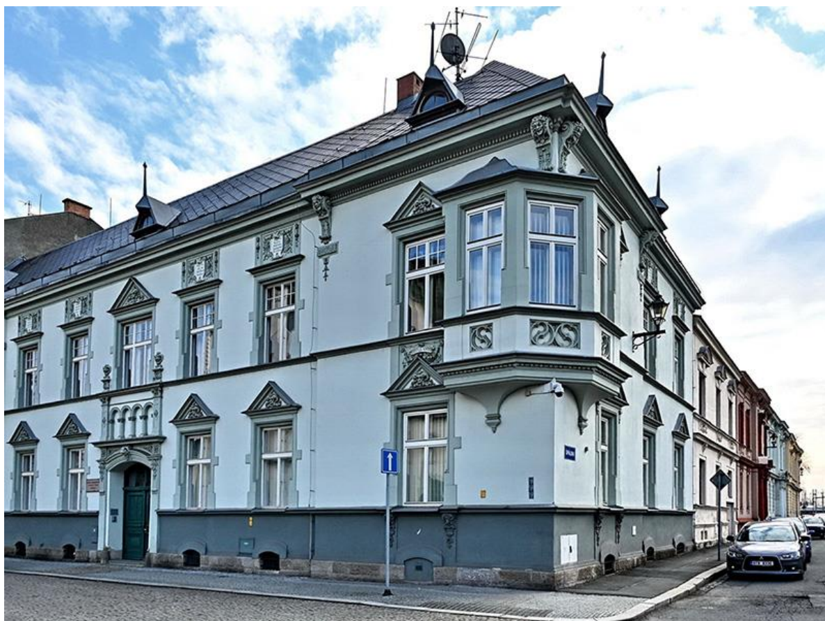
Budova Lidové konzervatoře, Wattova 5, Ostrava-Přívóz
