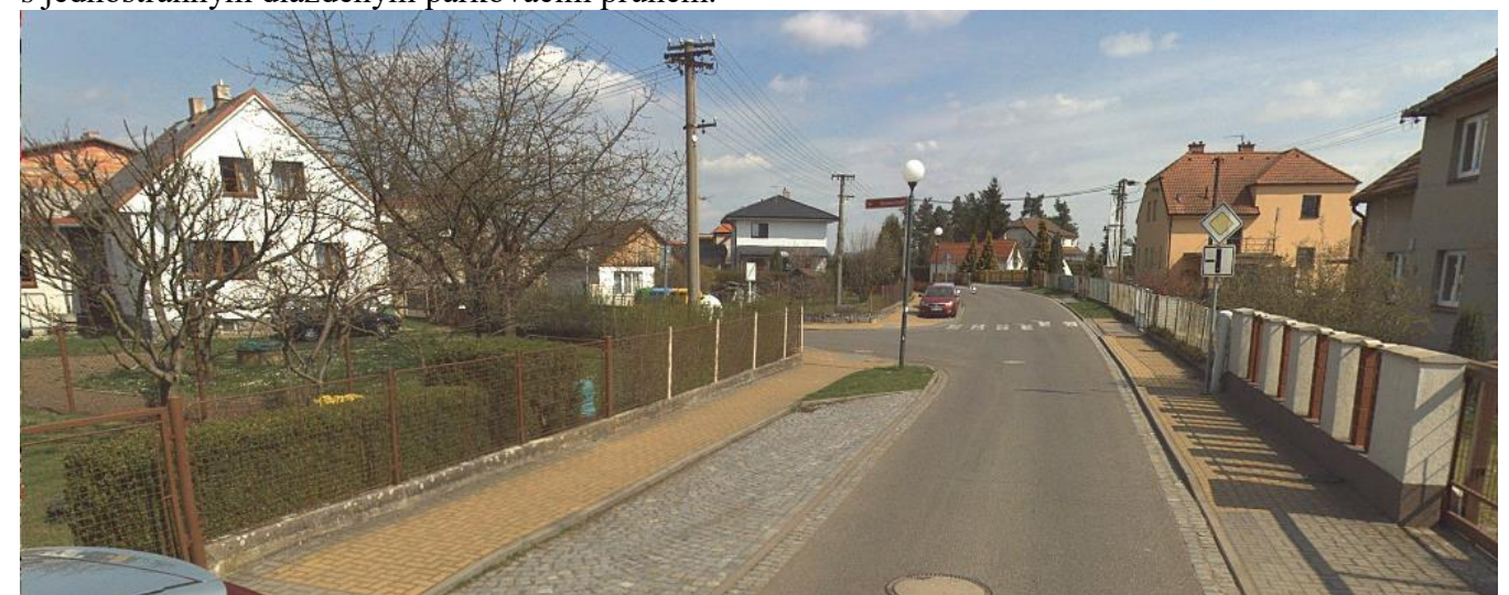
Koncový úsek jednopruhového obousměrného úseku s 3,5m širokou vozovkou délky cca 120m s jednostranným dlážděným parkovacím pruhem
