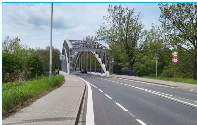
Ul. Hlučinská – most přes Odru
