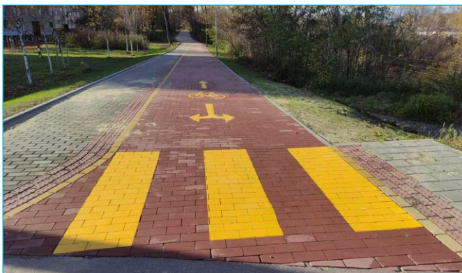
Stezka v úseku ul. Výškovická – lávka přes žel. trať
