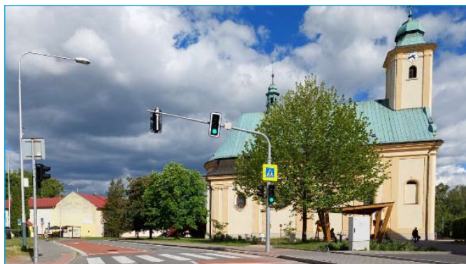
SSZ přechod pro chodce na ul. Blanické
