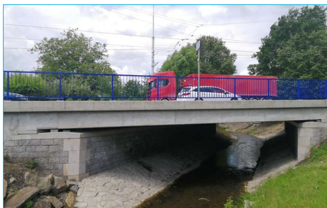
Ul. 17. listopadu – most přes Porubku
