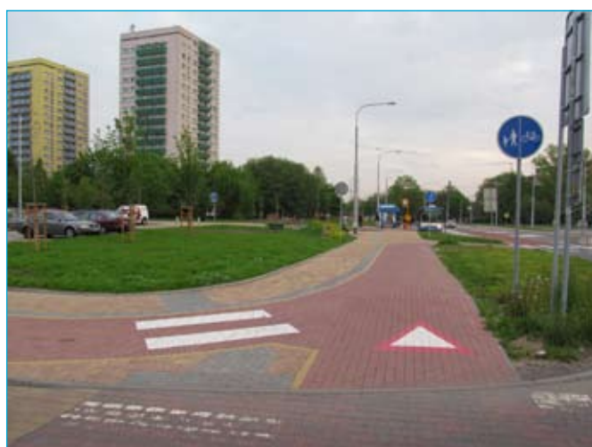
Sídliště Fifejdy - rekonstruovaný úsek trasy F
