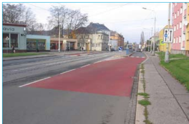
Zvýšení adheze vozovky, ul. Závodní
