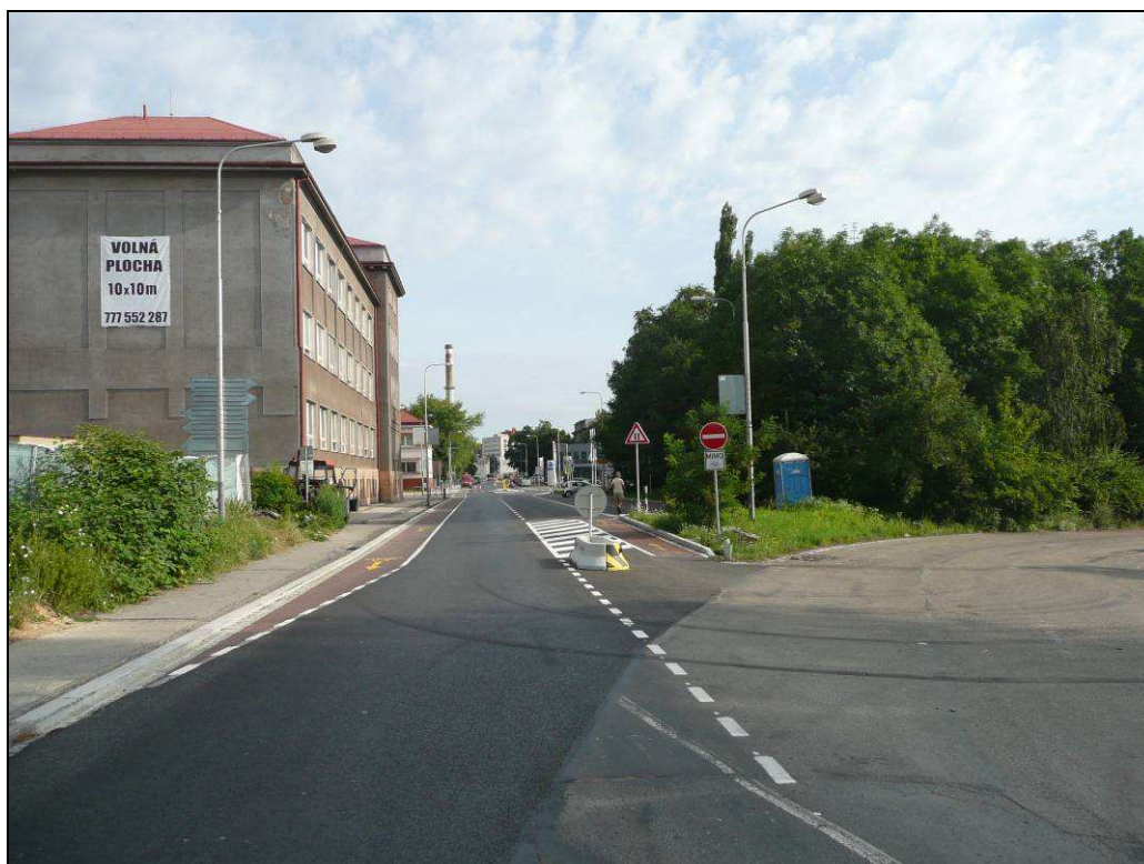
Příklad cyklistického pruhu v protisměru jednosměrné komunikace
