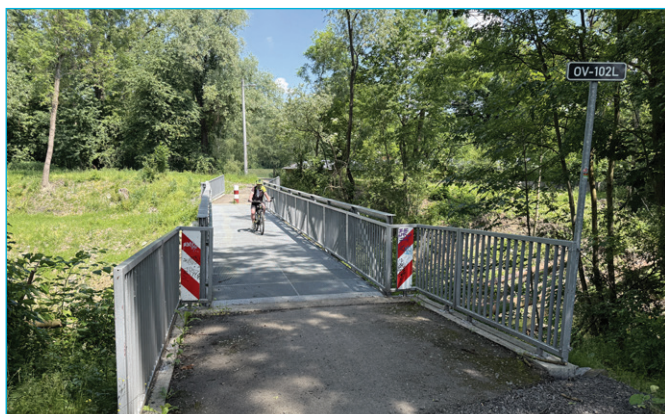
Lávka OV-102 L přes Černý potok
