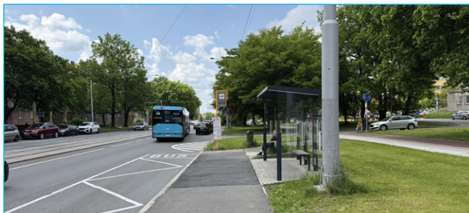
Rekonstrukce zastávky Fakultní nemocnice
