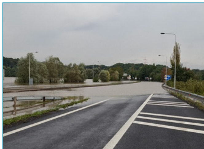
Ul. Mariánskohorská – povodně
