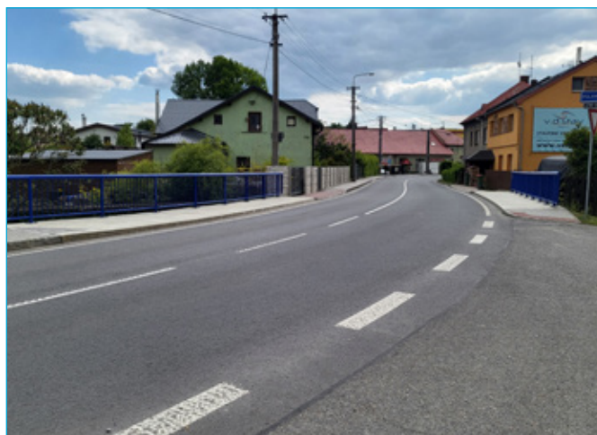
Most na ul. 1. května přes potok Polančice
