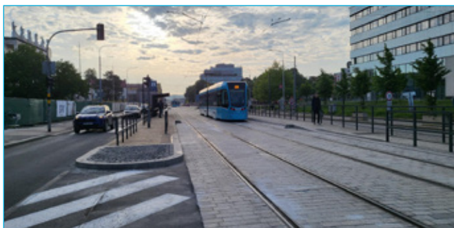
Modernizace zastávky Krajský úřad
