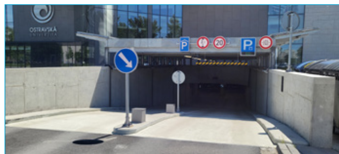
Podzemní HG pod objektem Ostravské univerzity
