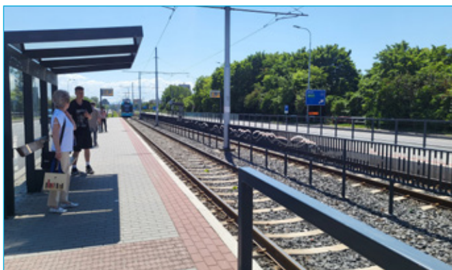
Opravená zastávka Tylova na ul. Plzeňské
