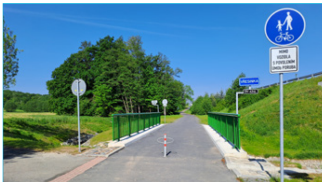
Lávka na cyklistické stezce přes Vřesinku
