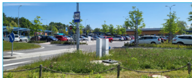
Parkoviště P+R na přestupním terminálu Hranečník
