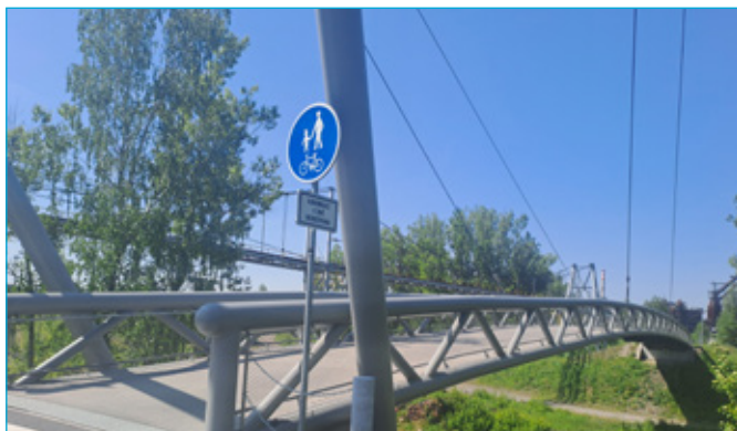
Lávka propojující DOV s centrem
