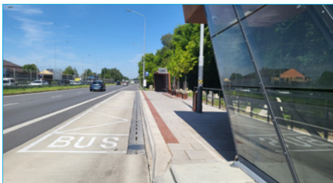
Opravená zastávka Dřevoprodej na ul. Místecké
