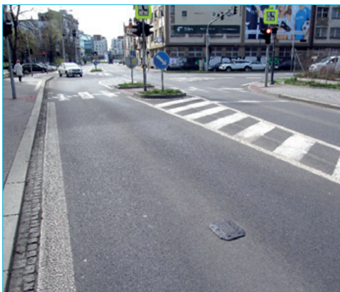
Sčítací zařízení NC 200 ul. Poděbradova
