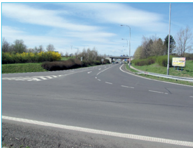
Rekonstrukce sil. II/478, ul. Paskovská
