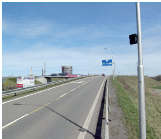
Sčítací radar TMS-SA4 JV rampa OK Severní spoj x Mariánskohorská
