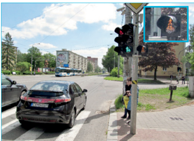
Kř. Opavská x Porubská – rekonstrukce světelně signalizačního zařízení s upozorněním na chodce a cyklisty
