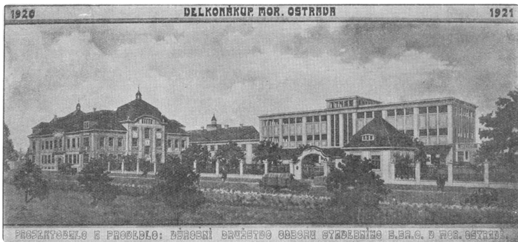
Centrála konzumního a úsporného družstva Budoucnost v Moravské Ostravě (tzv. Družstevní dům) byla společně s ostravskou pobočkou Velkonákupní společnosti družstev vybudována na Cihelní ulici v letech 1920–1921
